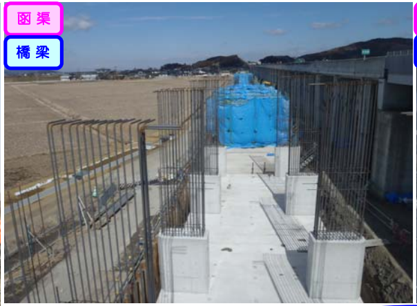
連続ラーメンボックス・橋台・橋脚を施工しています。
