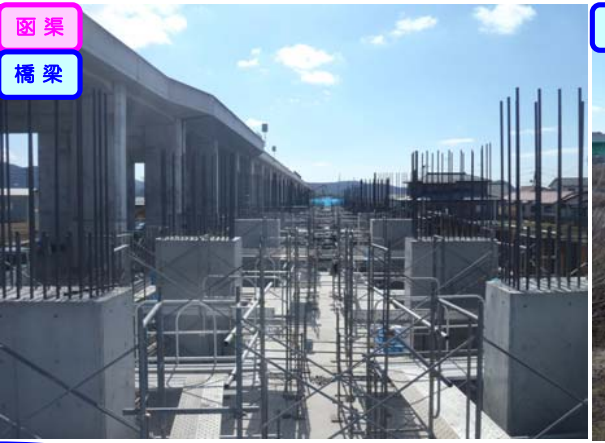
連続ラーメンボックス・橋台・橋脚を施工しています。
