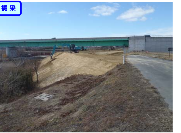
旧北上川左岸の仮締切堤及び県道迂回道路の造成中です。
