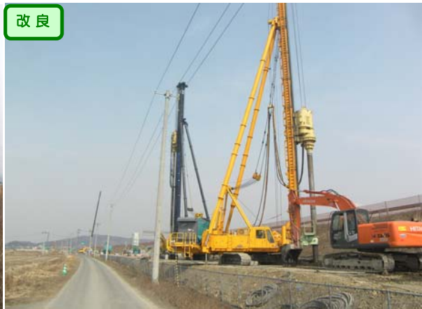
軟弱地盤対策としての地盤改良を施工しています。
