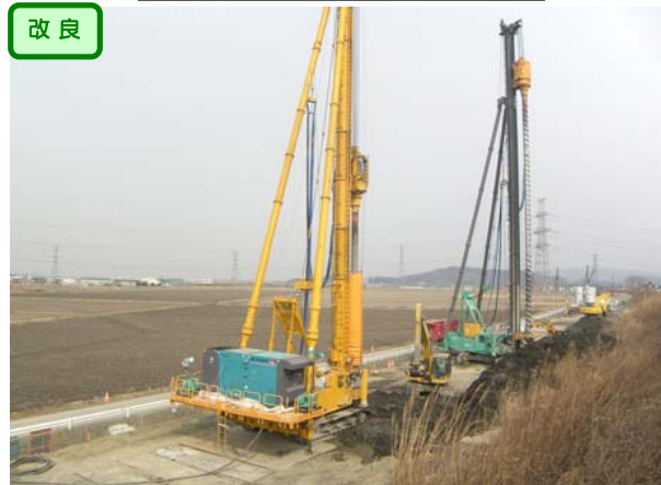
軟弱地盤対策としての地盤改良を施工しています。
