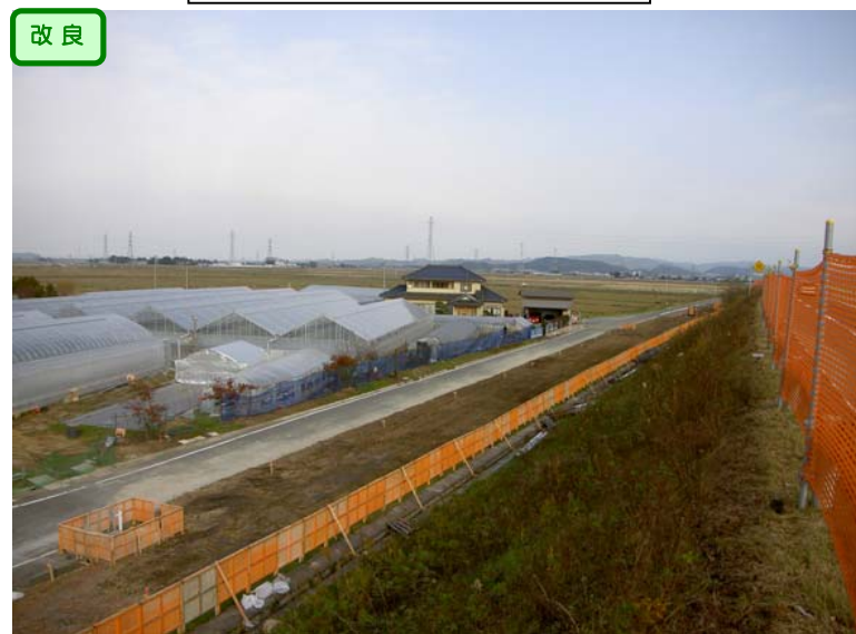
軟弱地盤対策としての地盤改良が完了しました。
