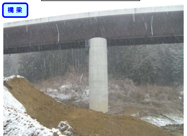
② 左側からNo.456を望む 山居沢橋 橋脚(P1)
