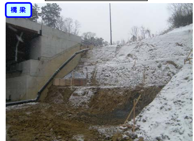
① No.454から起点側を望む 山居沢橋 橋台(A1)
