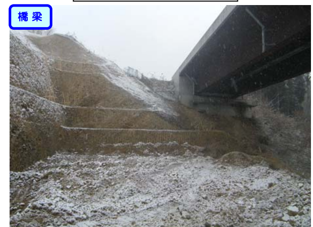
③ No.457から終点側を望む 山居沢橋 橋台(A2)
