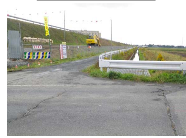
④ No.1066から起点側を望む
