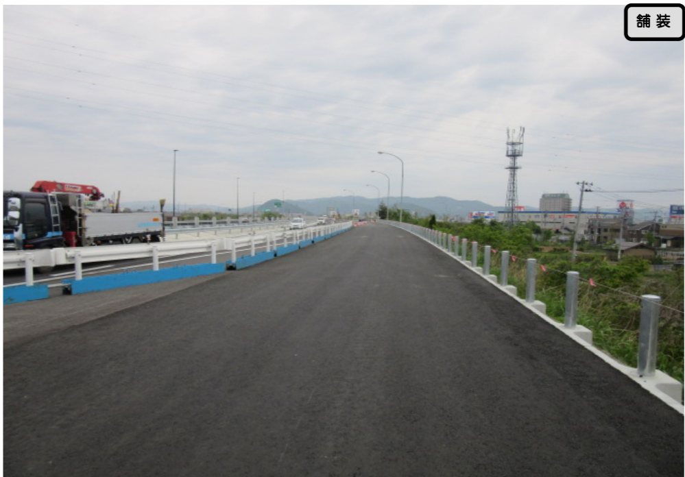
② 起点側から終点側を望む (上り線リフレッシュ工事中)
