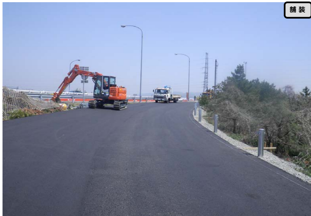
① 起点側から終点側を望む 石巻港ICランプ
