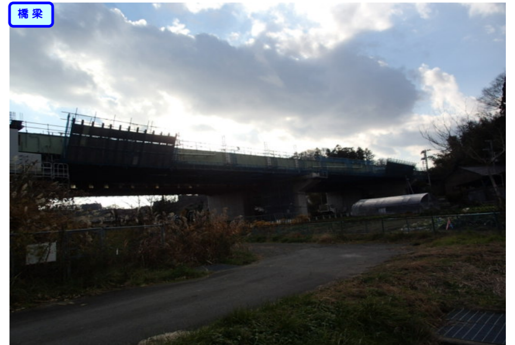
④ 終点側から起点側を望む 上小松橋全景
