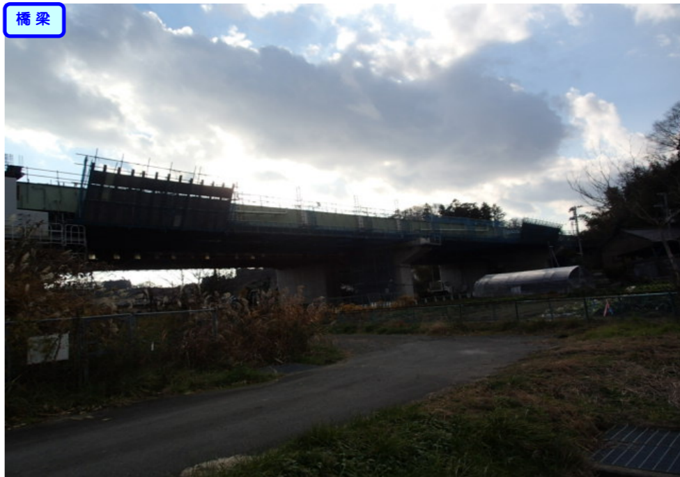
④ 終点側から起点側を望む 上小松橋全景
