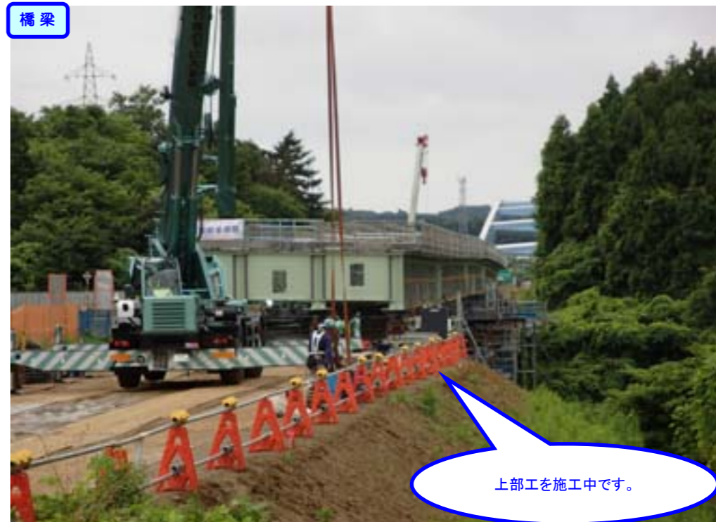
③ 終点側から起点側を望む 新田橋
