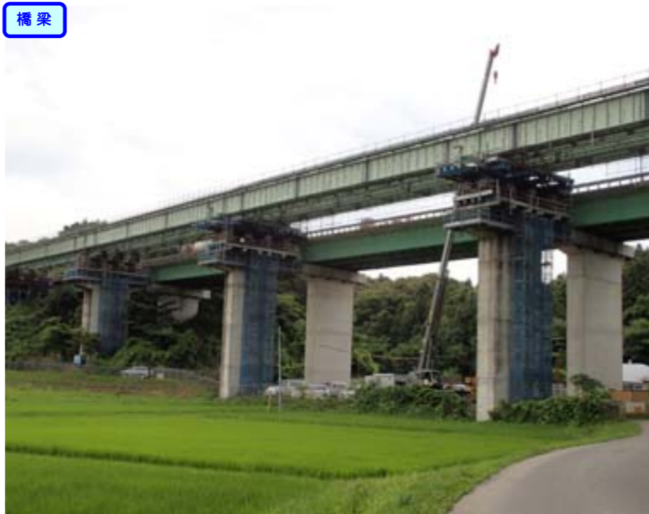
② 起点側から終点側を望む 新田橋
