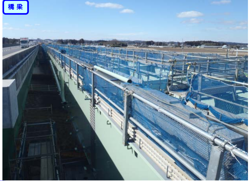
橋桁送出し・降下が完了し仮設備を解体しています。
