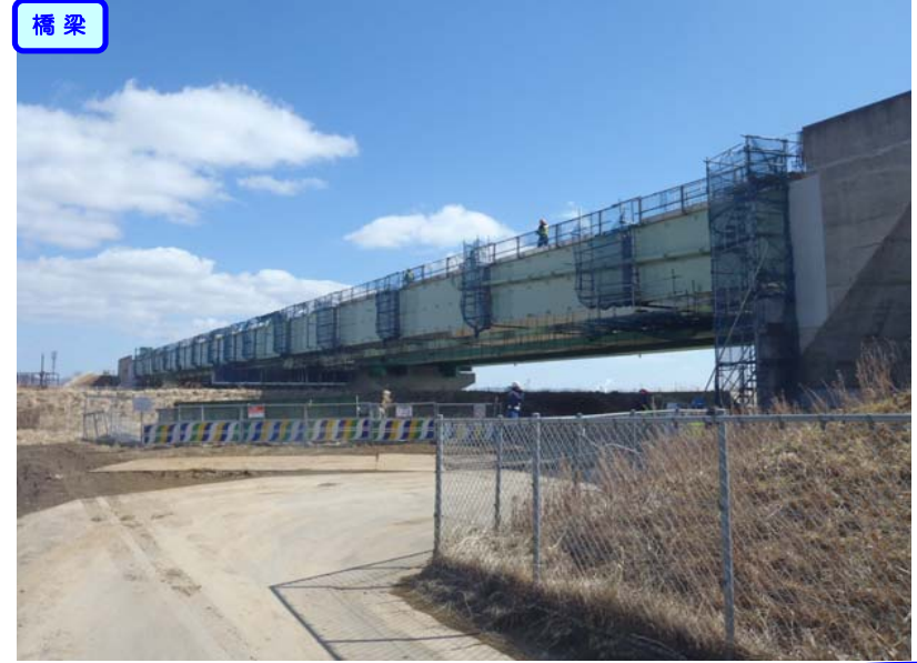
橋桁送出し・降下が完了し仮設備を解体しています。
