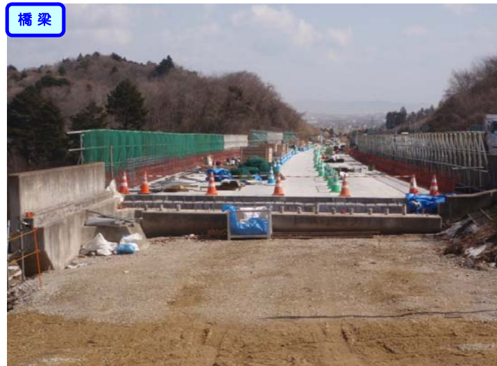
橋桁送出し・設置が完了しました。
