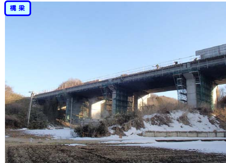
橋桁送出し・設置が完了しました。
