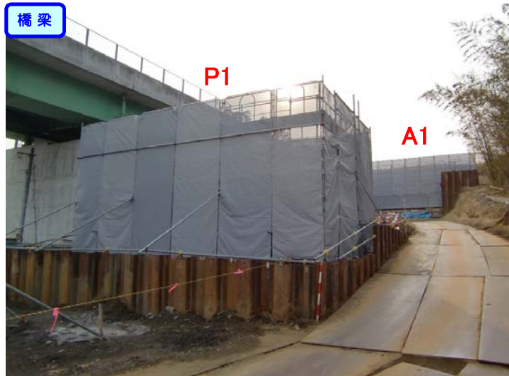
鉄筋・型枠組立作業をしています。
