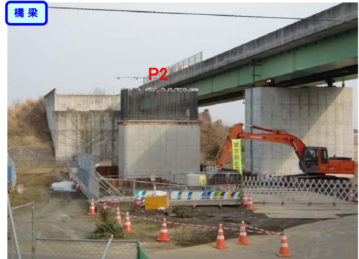
鉄筋・型枠組立作業をしています。
