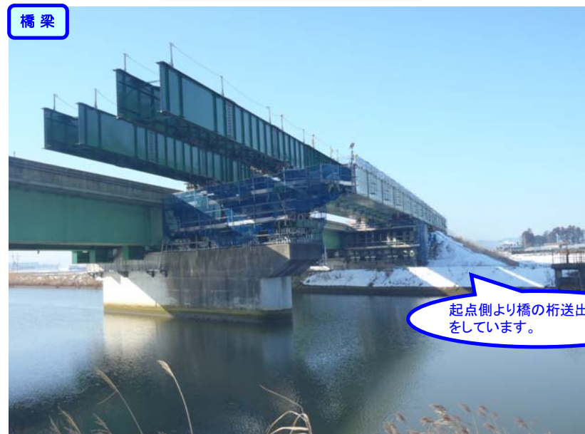
② No780から起点側を望む 矢本大橋
