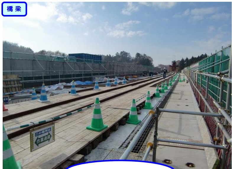
② No.532から起点側を望む 旗沢橋
