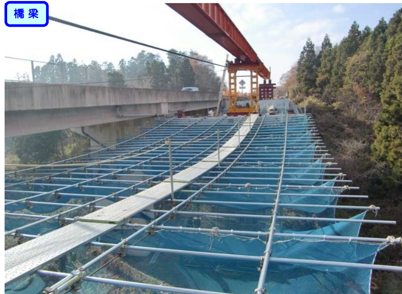
③ No.530から起点側を望む 旗沢橋
