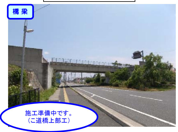
② 左側からNo.928を望む 川南こ道橋 全景
