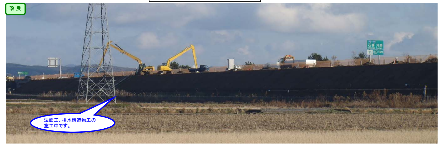
① 左側からNo.860～No.930から終点側を望む
