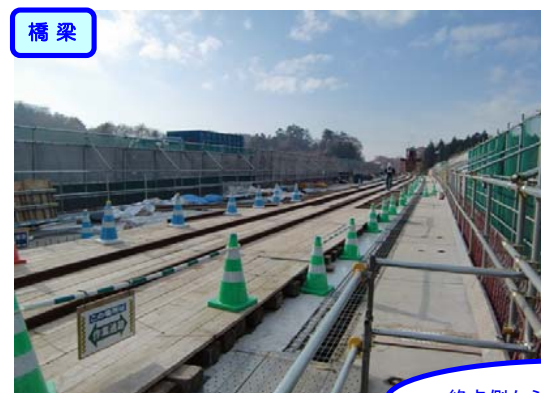
終点側から橋桁設置中です。
