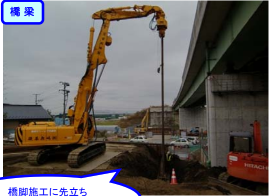
橋脚施工に先立ち 仮設土留工施工中です。
