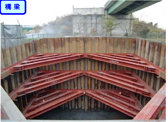
⑥ No.570から終点側を望む 上小松橋 橋脚(P2)
