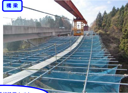
終点側から橋桁設置中です。
