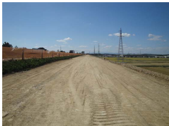
② No.882から起点側を望む
