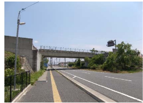
④ 左側からNo.928を望む 川南公道橋 全景
