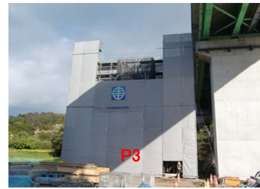
⑤ 高松橋 橋脚(P3)
