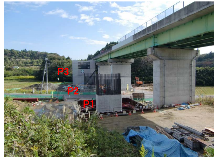
② No.450から終点側を望む 高松橋 全景 橋脚(P1 P2 P3)
