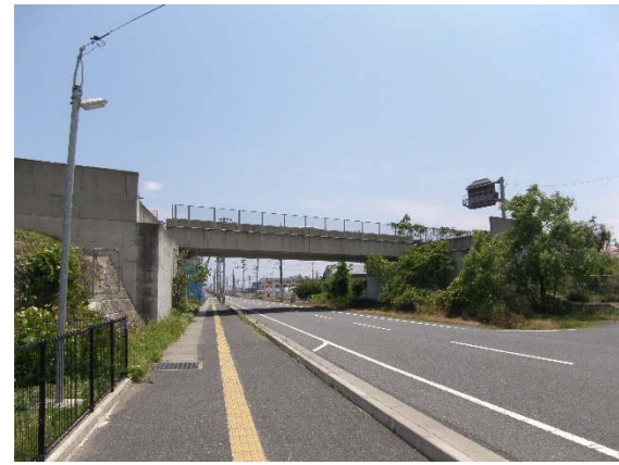
④ 左側からNo.731を望む 川南公道橋 全景
