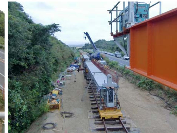
⑥ No.533から終点側を望む旗沢橋
