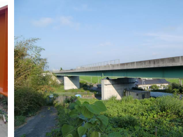
⑦ No.565から終点側を望む上小松橋 全景
