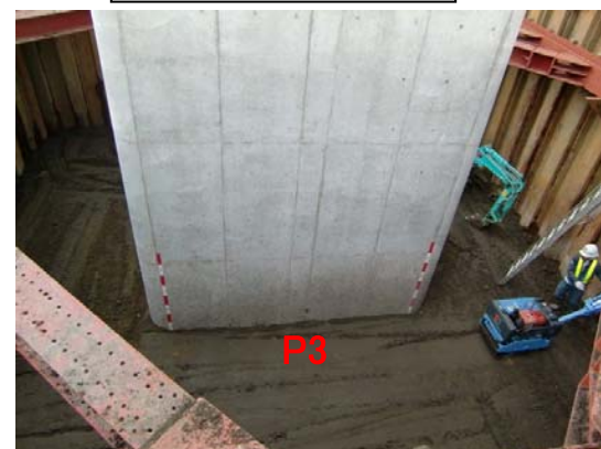
⑤ 高松橋 橋脚(P3)
