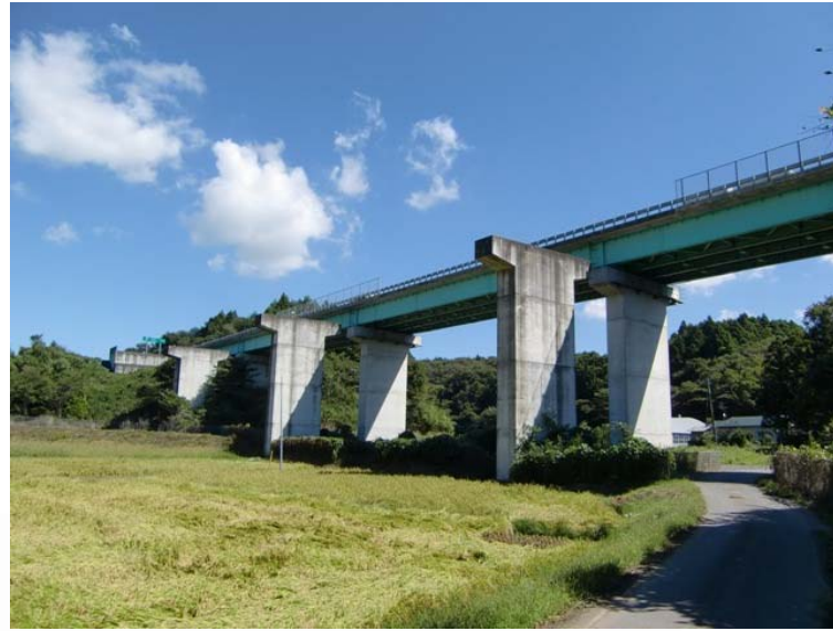
① No.393から終点側を望む 新田橋 全景
