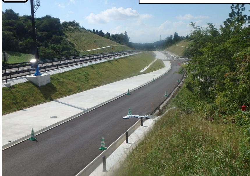
舗装 ② No.387左側から起点側を望む
