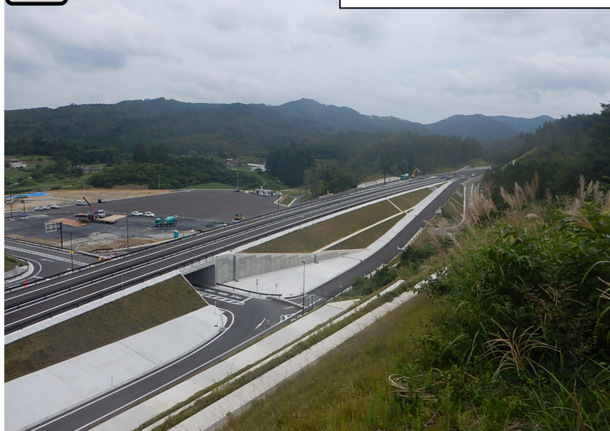
舗装 ① No.374右側から終点側を望む
