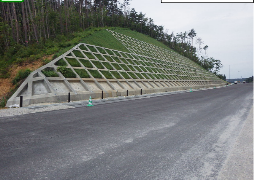
改良 ③ No.391から起点側を望む
