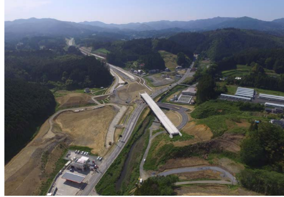
④ 志津川ICから起点側を望む
