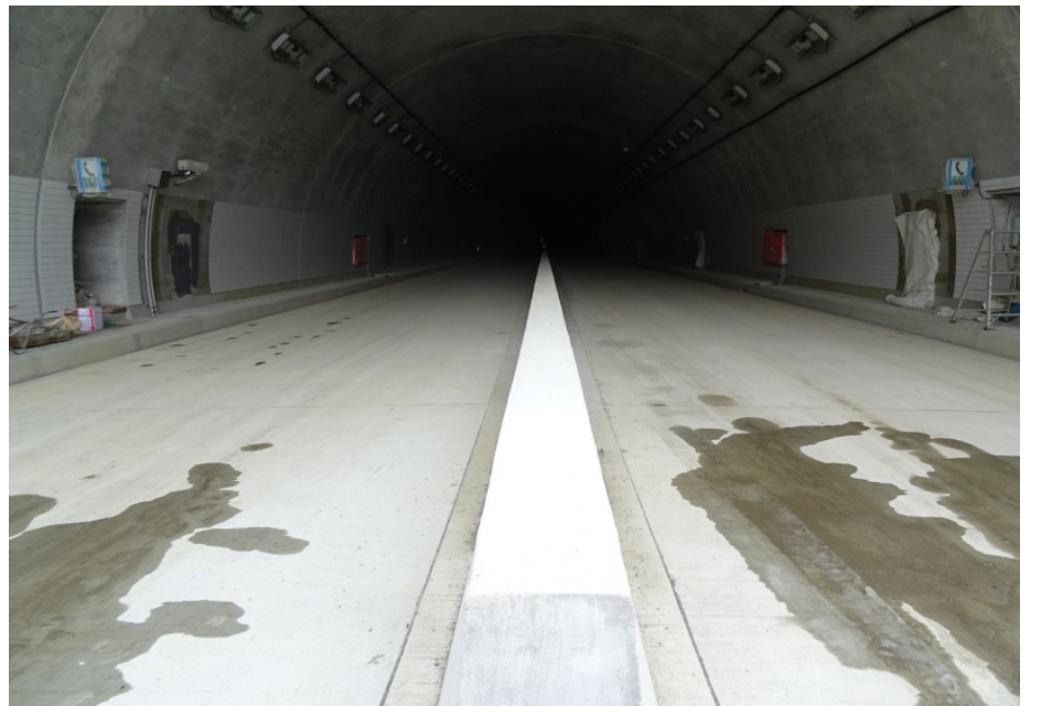
④ 起点側から終点側を望む (仮)志津川トンネル
