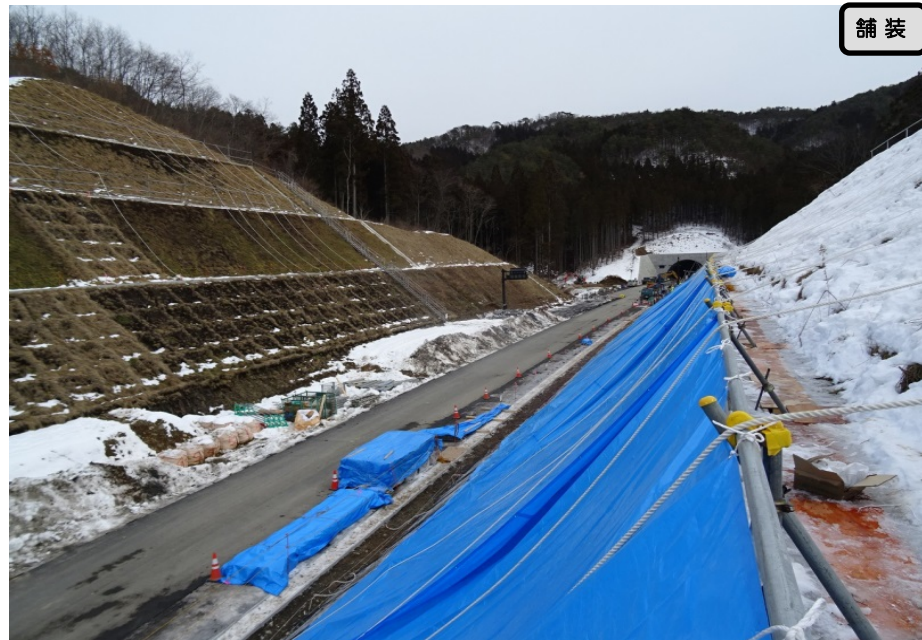
③ 起点側から終点側を望む
