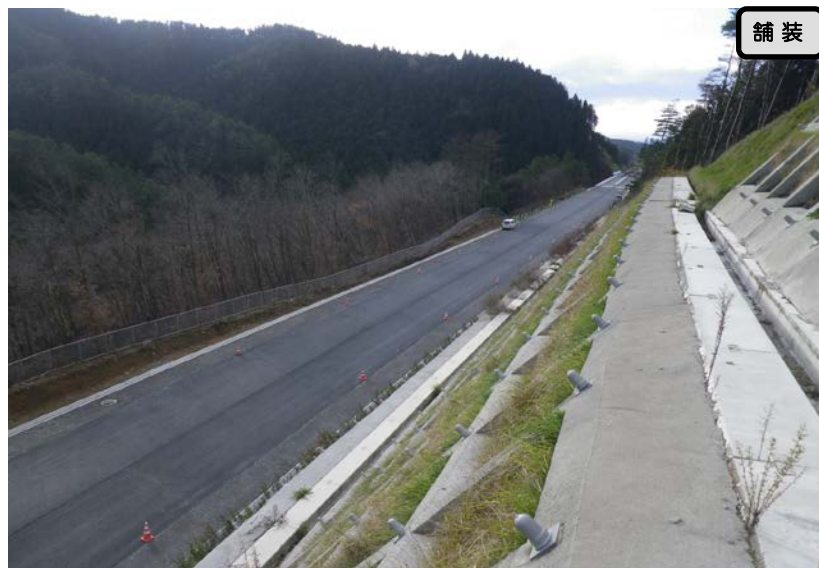
① 終点側から起点側を望む
