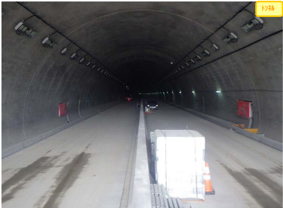
① 起点側から終点側を望む
