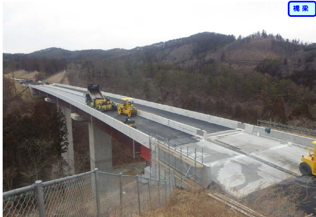
③ 終点側から起点側を望む 寺沢川橋
