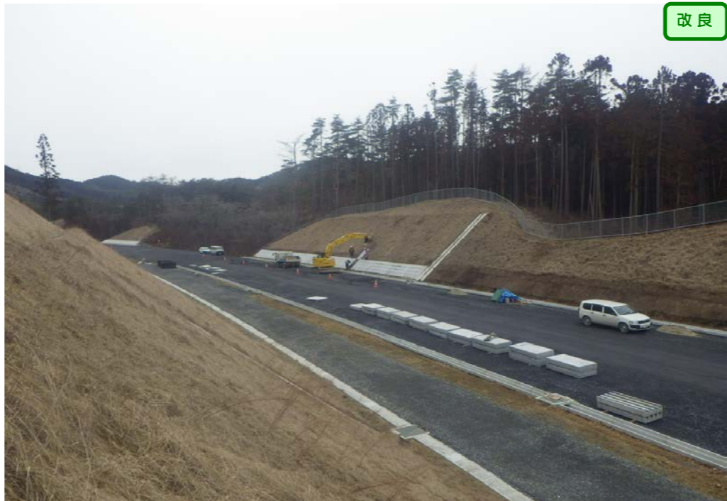
② 終点側から起点側を望む
