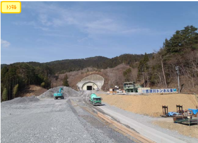
④ No.615から起点側を望む 志津川トンネル起点側(東工区) 坑口
