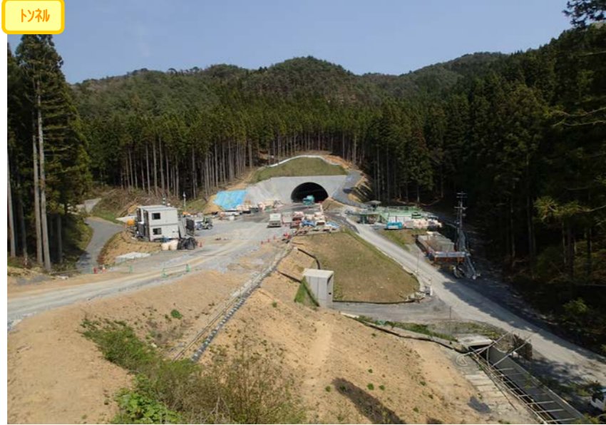
① No.539から終点側を望む 志津川トンネル起点側(西工区) 坑口
