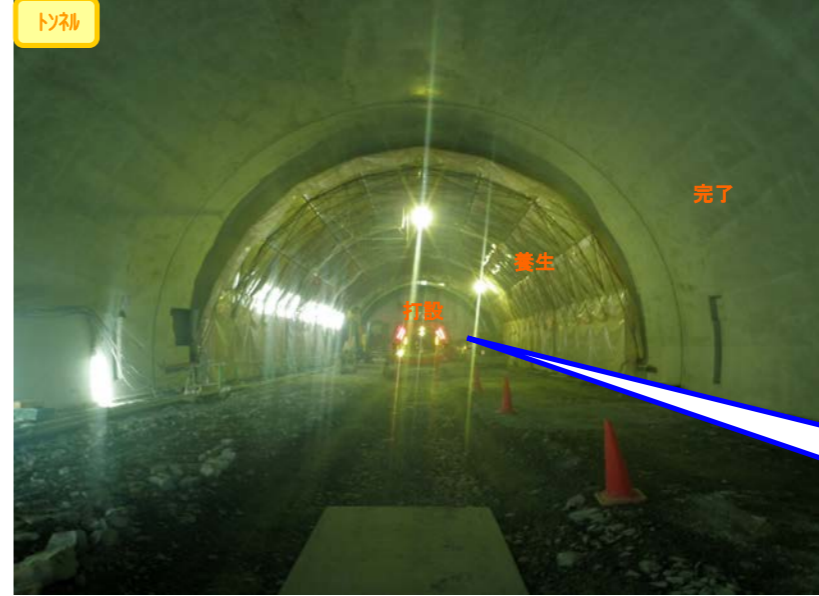
② 坑内を望む 志津川トンネル起点側(西工区)
