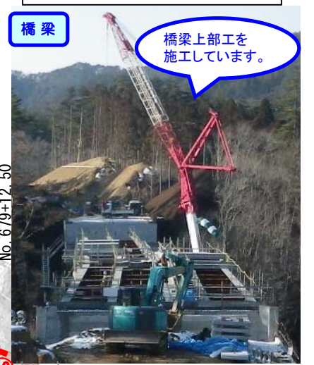
⑩ No.681から起点側を望む 寺沢川橋
