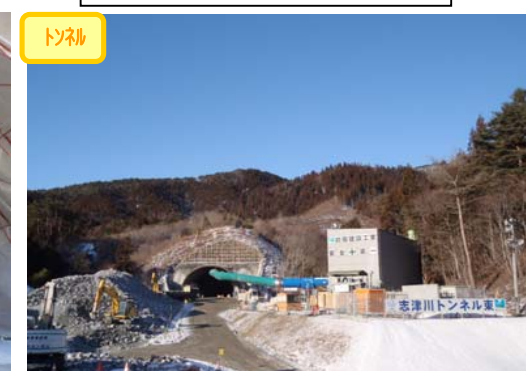
⑦ No.615から起点側を望む 志津川トンネル起点側(東工区) 坑口
