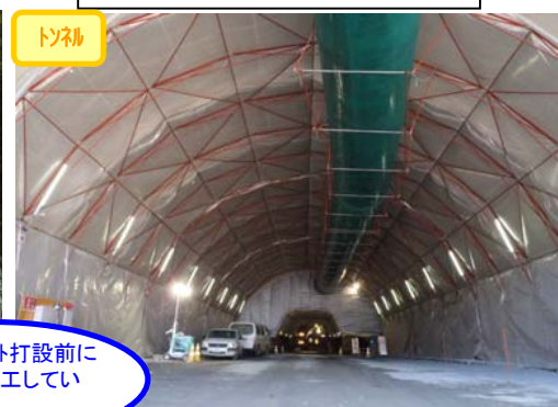
⑥ 坑内を望む 志津川トンネル起点側(東工区)
