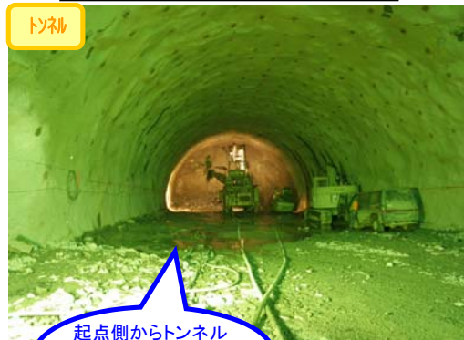
③ 坑内(切羽)を望む 志津川トンネル起点側(西工区)
