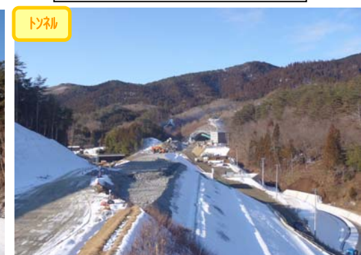
⑧ No.630から起点側を望む
