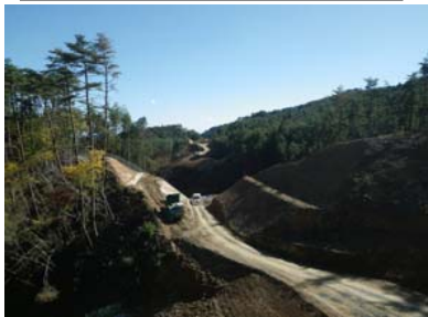
① No.700から起点側を望む
