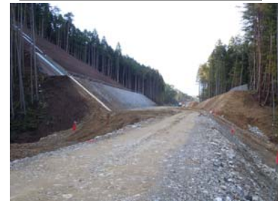
⑥ No.755から起点側を望む
