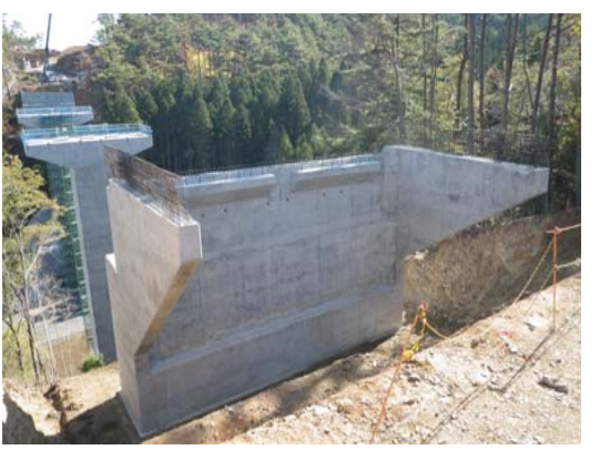
⑧ No.672から終点側を望む 寺沢川橋 全景
