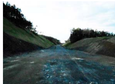
④ No.425から起点側を望む
