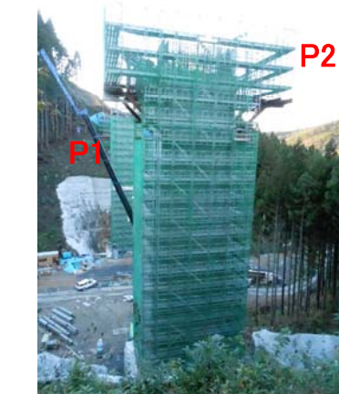
⑫ No.489から起点側を望む 大岩久保沢橋 橋脚(P2)
