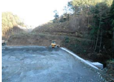
⑦ No.449から終点側を望む
