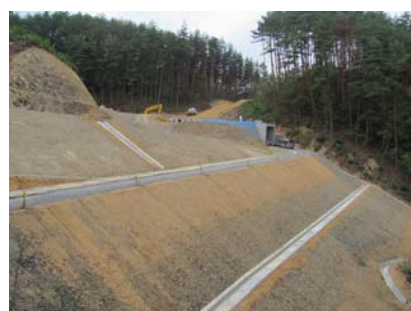
⑥ No.454から起点側を望む
