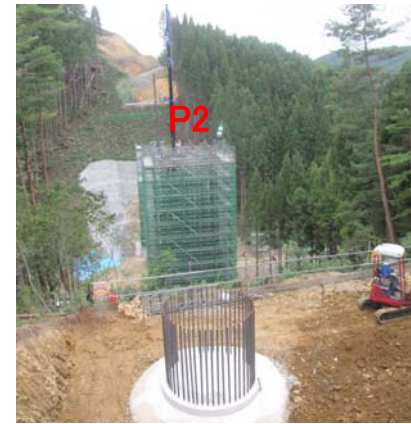
⑩ No.490から起点側を望む 大岩久保沢橋 橋脚(P2)
