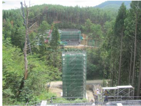
① No.431から起点側を望む 福平橋
