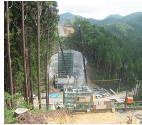
③ No.490から起点側を望む 大岩久保沢橋
