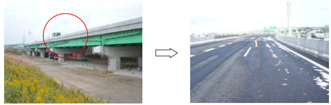
⑦ 市川地区 P 1 1 2 付近
