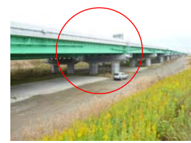
⑥ 谷地地区 P104付近
