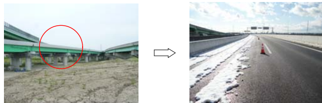
⑧ 砂押地区 P 1 2 7 付近
