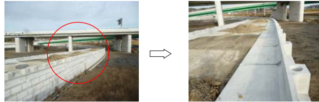
⑤ 南宮地区 Bランプ付近 (防護柵設置完了)
