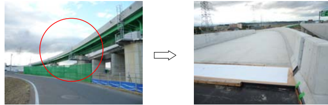
⑤ 山王地区 Dランプ付近
