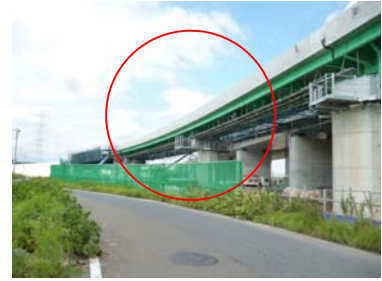
⑤ 山王地区 Dランプ付近 (壁高欄完成)
