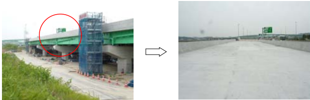
⑦ 市川地区 P 1 1 2 付近
