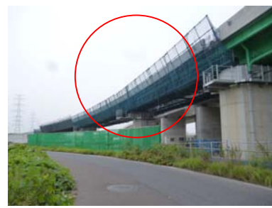
⑤ 山王地区 Dランプ付近 (壁高欄完成)
