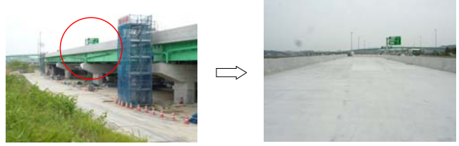
⑦ 市川地区 P 1 1 2 付近
