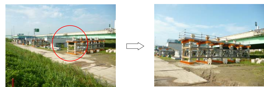
⑦ 市川地区 P 1 1 2 付近 (架設準備工)
