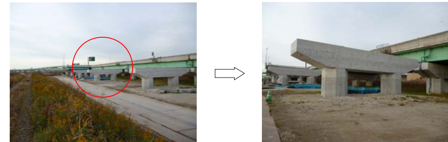
⑦ 市川地区 P 1 1 2 付近
