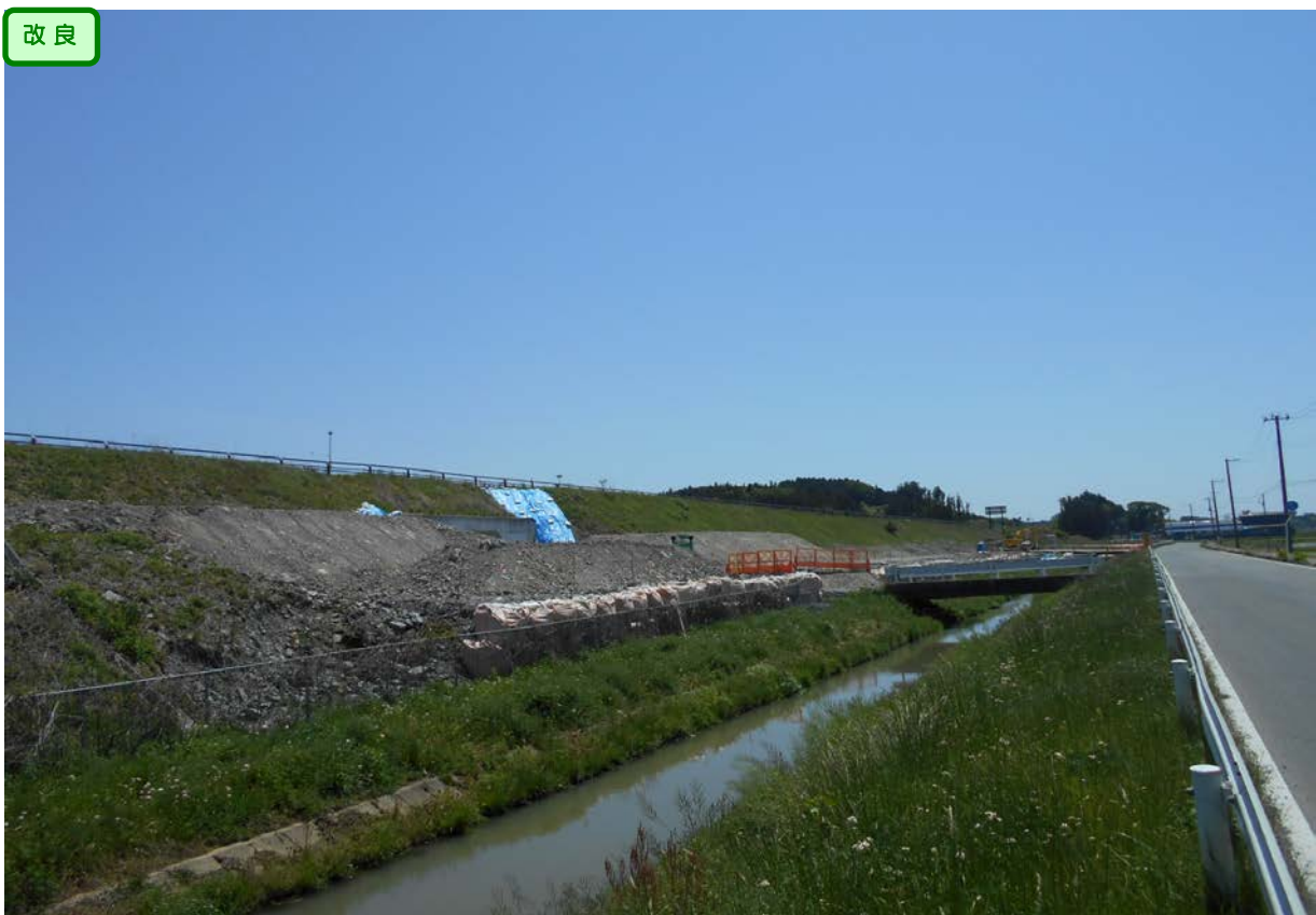
② No.82から起点側を望む
