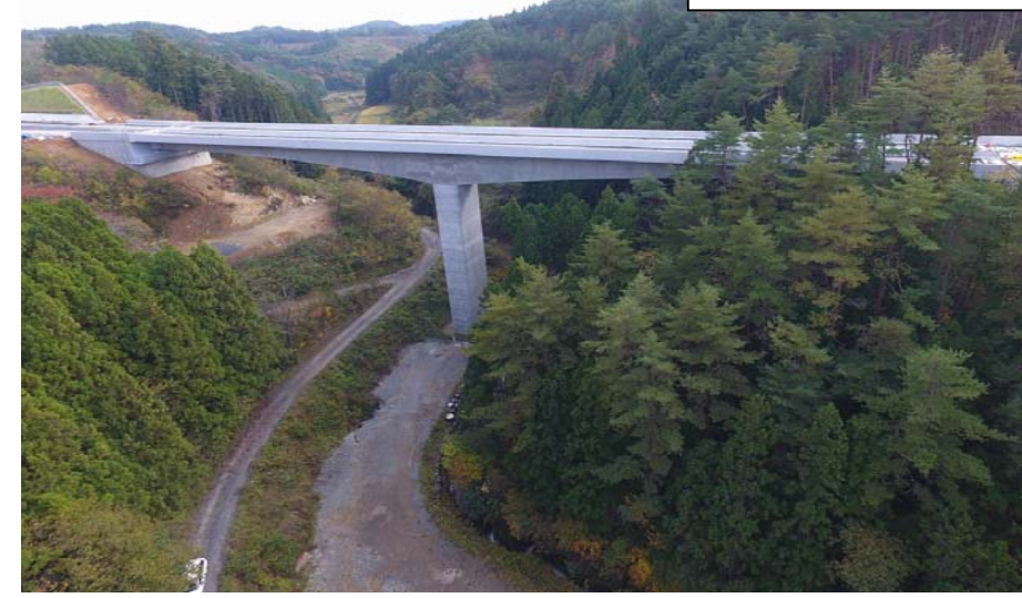
④ 山側から海側を望む (蛇王橋上部工)
