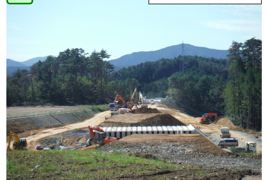
④ No.146付近から起点側を望む
