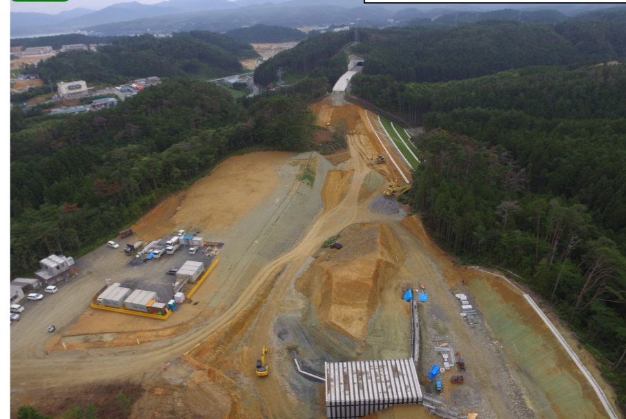
④ No.146付近から起点側を望む
