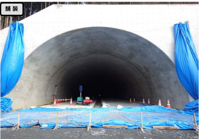
③ 起点側から終点側を望む (仮)1号トンネル
