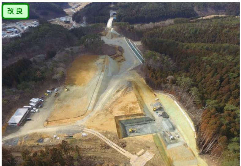
④ No.146付近から起点側を望む
