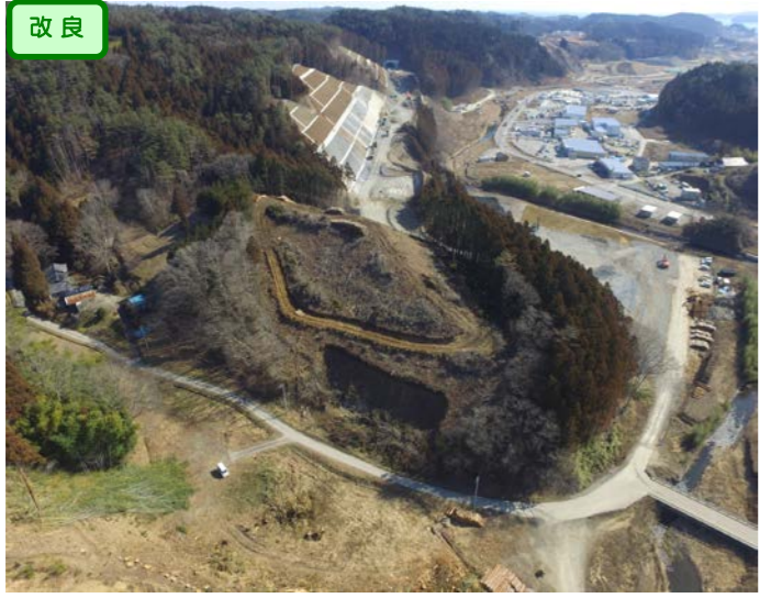
① 起点側から終点側を望む(小森地区)
