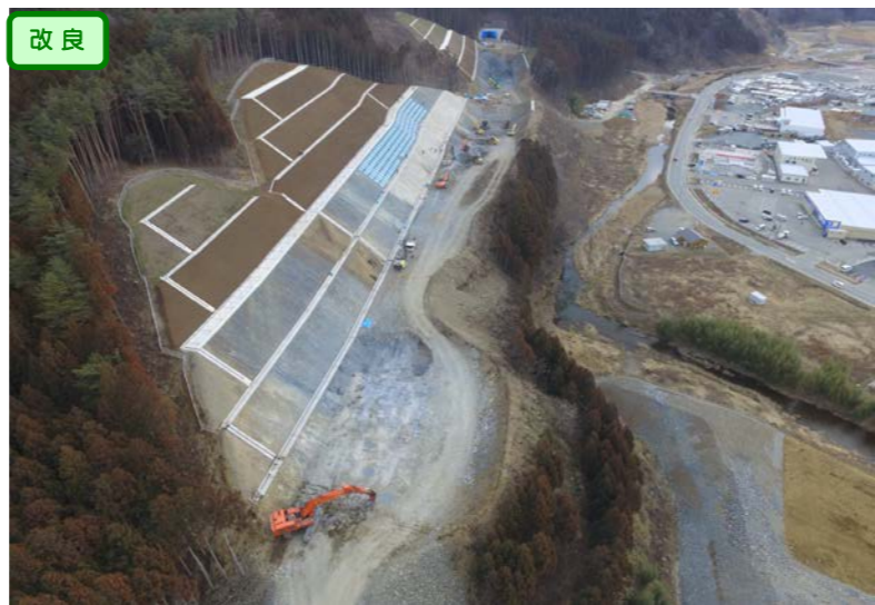
② 起点側から終点側を望む(熊田地区)
