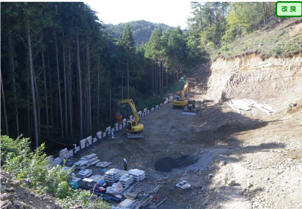
② No.128付近(補強土壁工)
