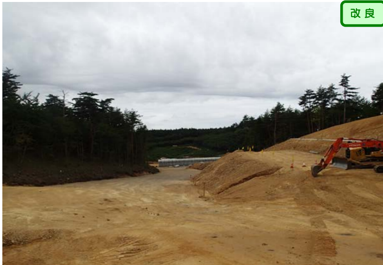
⑤ No.180から起点側を望む
