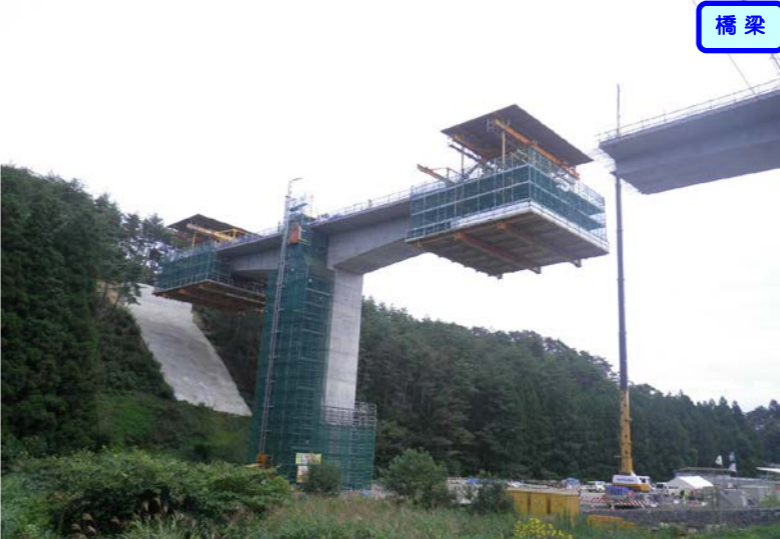
④ 橋梁左側からP2、A2を望む 新井田川橋
