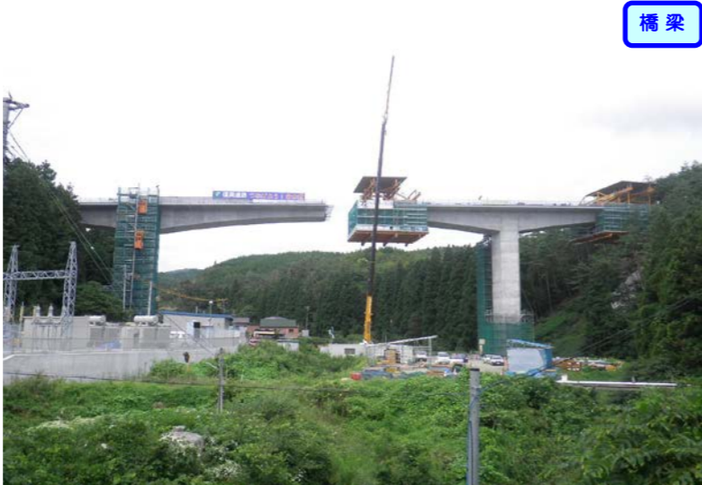
③ 国道45号から橋梁右側を望む 新井田川橋
