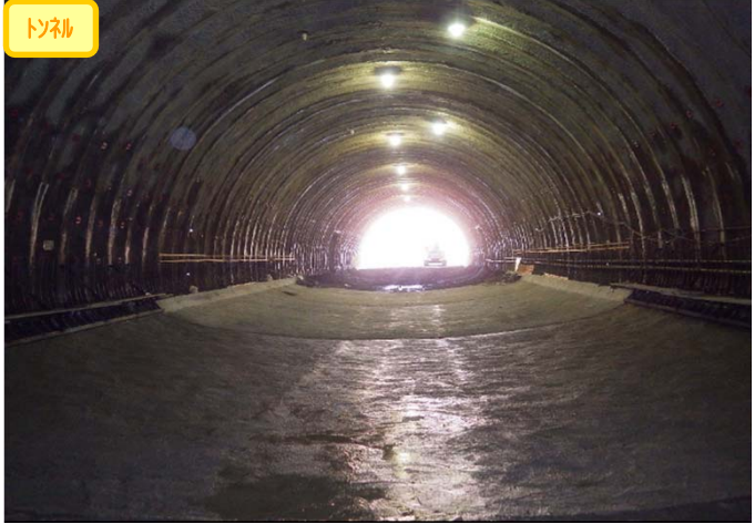
① 1号トンネル
